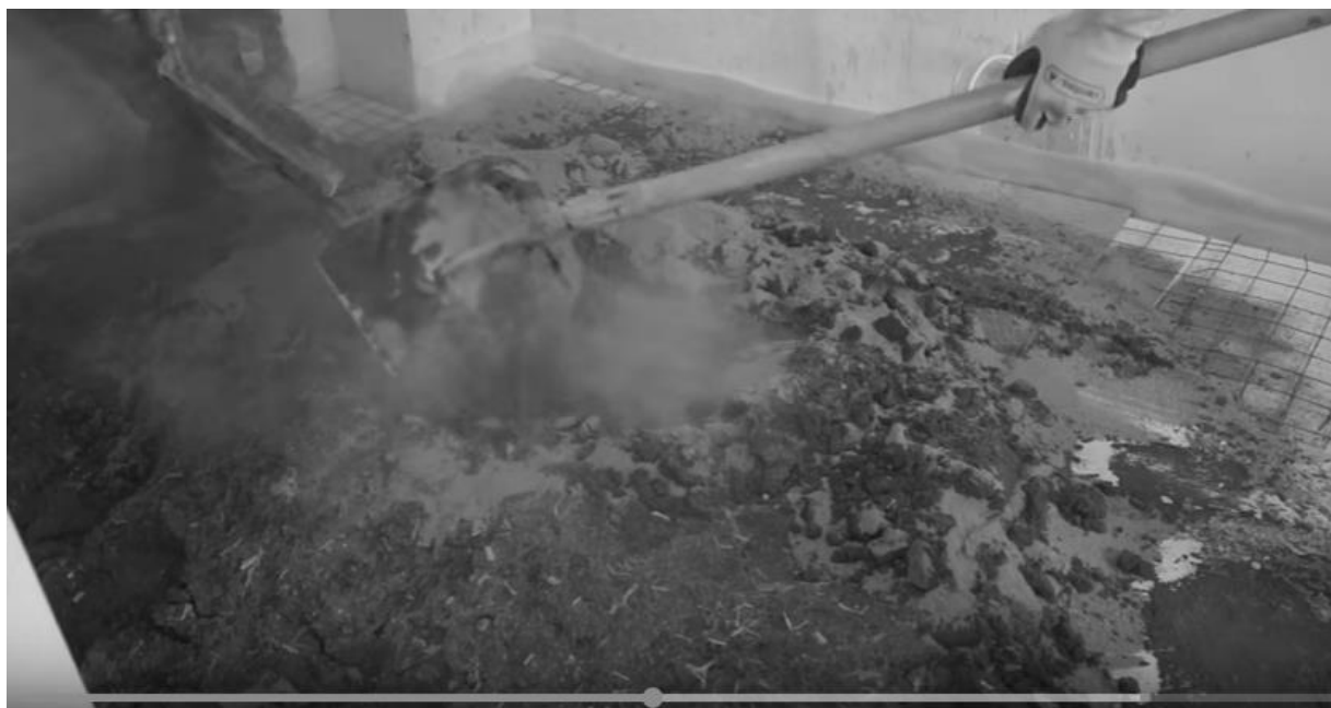
Рис. Е. 5. Підготовлення пісково-цементної суміші для облаштування напівсухої підлогової стяжки.
