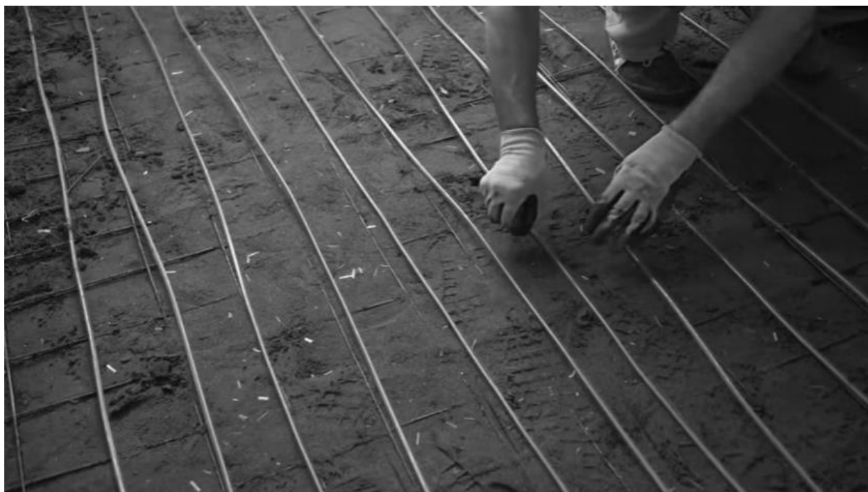
Рис. Е. 7. Встановлення електричного електричного кабеля-нагрівника теплої підлоги.
