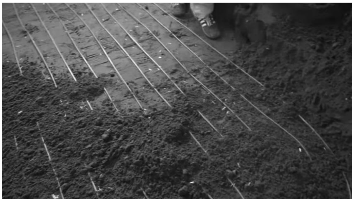
Рис. Е. 8. Засипання пісково-цементної суміші.
