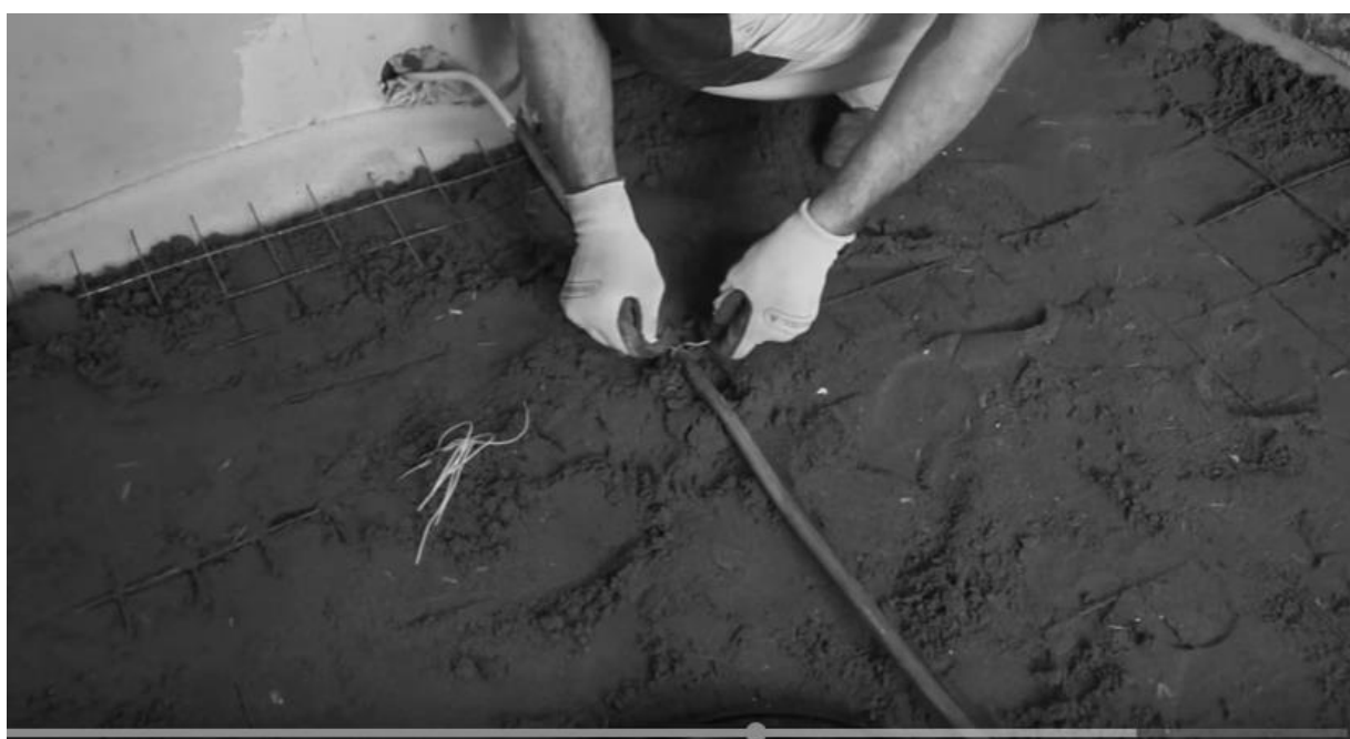
Рис. Е. 6. Встановлення термодатчика з термопарою;
