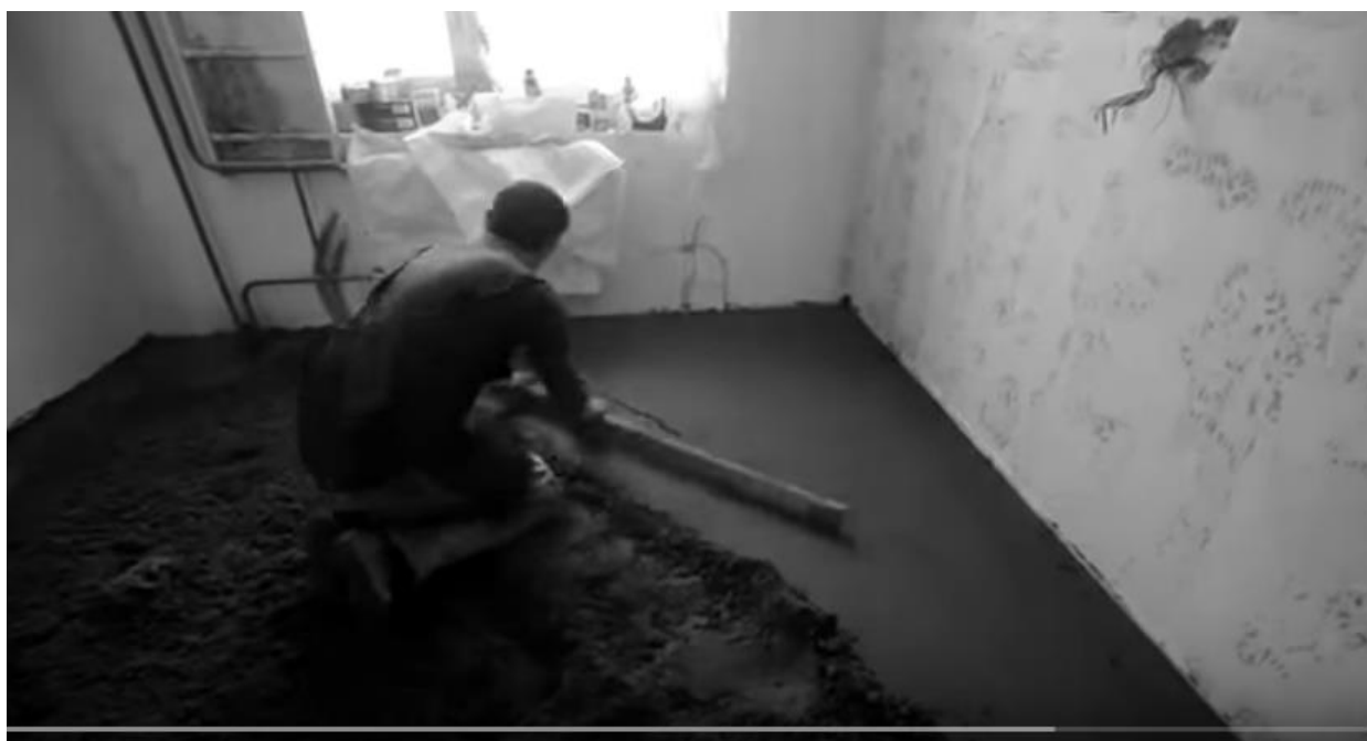
Рис. Е. 10. Ручне вирівнювання пісково-цементної суміші.
