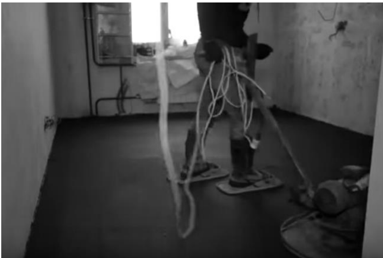
Рис. Е. 11. Фінішне вирівнювання пісково-цементної суміші за допомогою електричної шліфувальної машини.
