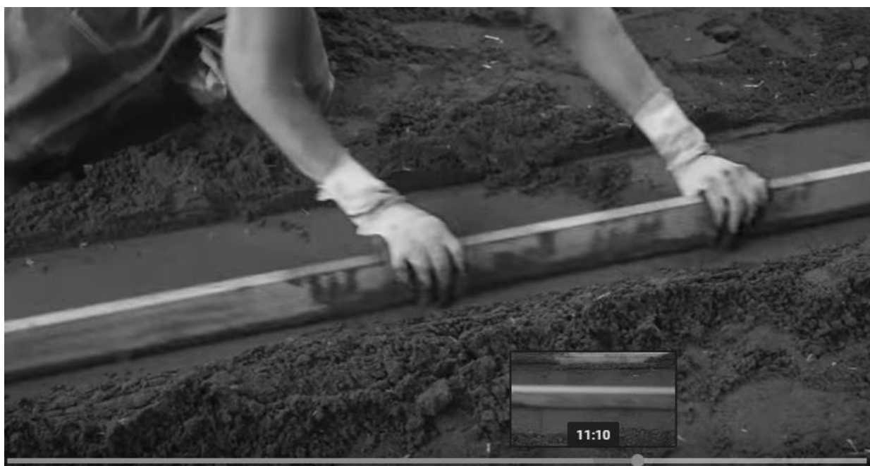
Рис. Е. 9. Ручне вирівнювання пісково-цементної суміші.
