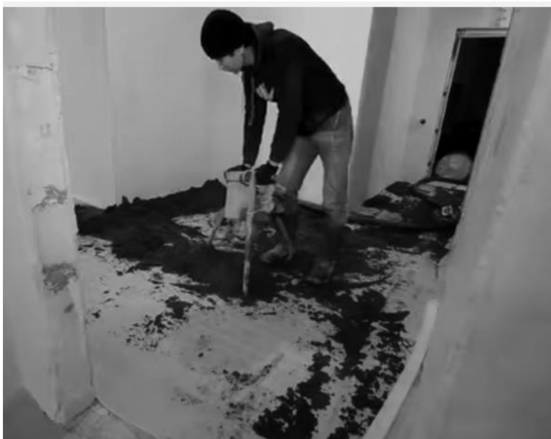
Рис. Е. 4. Підготовлення пісково-цементної суміші для облаштування напівсухої підлогової стяжки.
