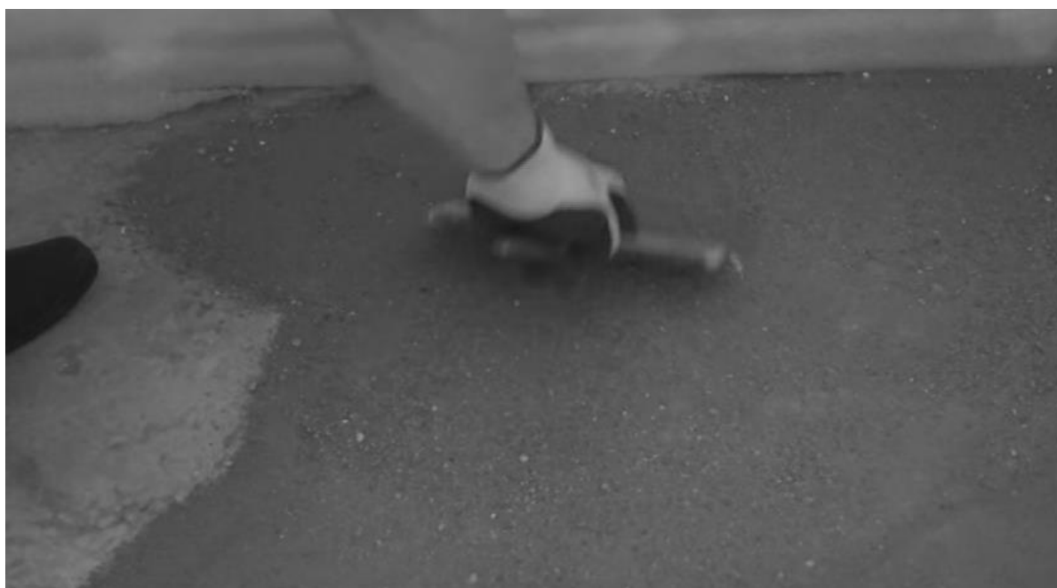
Рис. Е. 2. Підготовка плит перекриття до облаштування підлоги з підігріванням.
