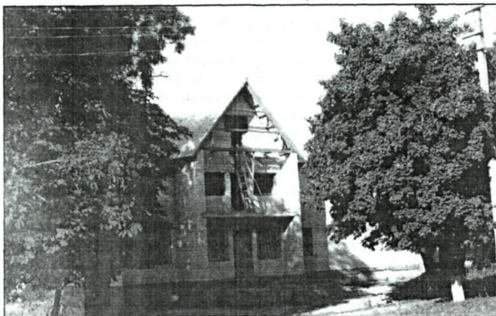
Рис.13. Будується адмінприміщення держлісгоспу.
