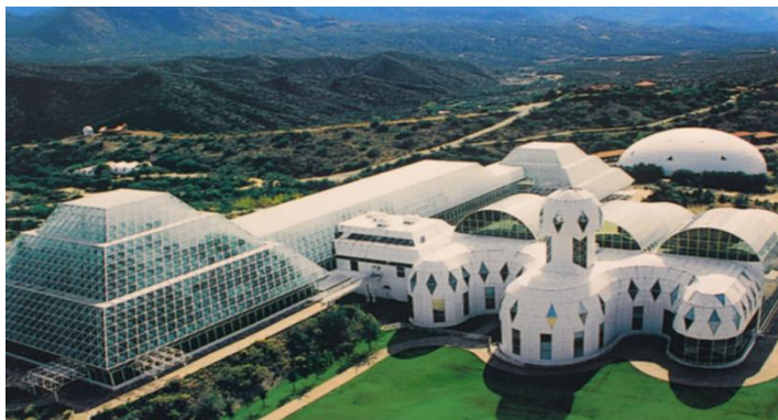
Рис.1. «Біосфера 2» – гігантський герметизований комплекс споруд з бетону, сталевих труб і 5600 скляних панелей
